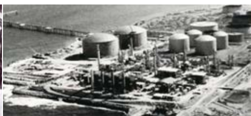
② The Abu Dhabi LNG project (UAE)
