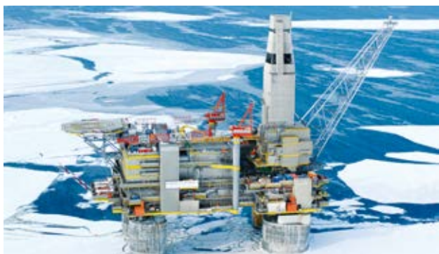
LNG business / Sakhalin II LNG project (Russia)
